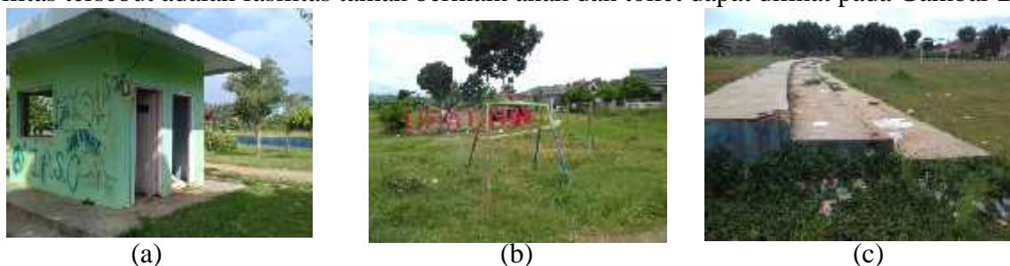
Gambar 2. (a) Fasilitas toilet yang rusak (b) Fasilitas tempat bermain anak yang tidak dirawat (c) Sampah yang berserakan di Taman Kalpataru.
